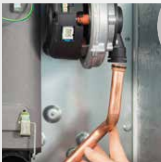
A gázcső kikötése
