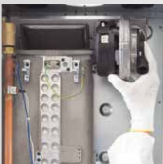
Az égő egység eltávolítása
