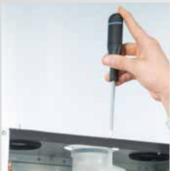
Az égéstermék-gyűjtő rögzítő csavar eltávolítása
