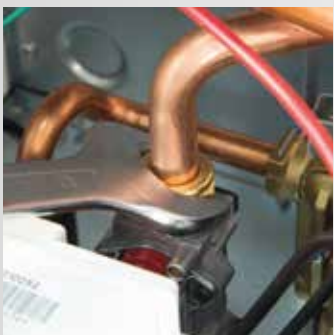
A gázszелеphez menő cső kioldása
