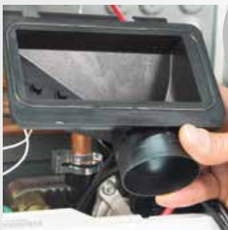
A kondenzvíz gyűjtő átvizsgálása
